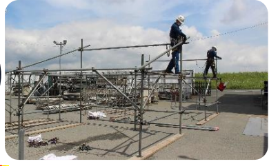
←図面を見て、単管で組み立てていきます
